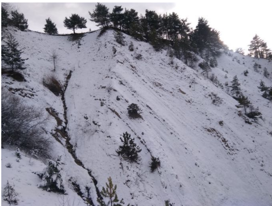
Vue de l'ossature rocheuse (soulignée par la neige) en rive gauche de la combe
