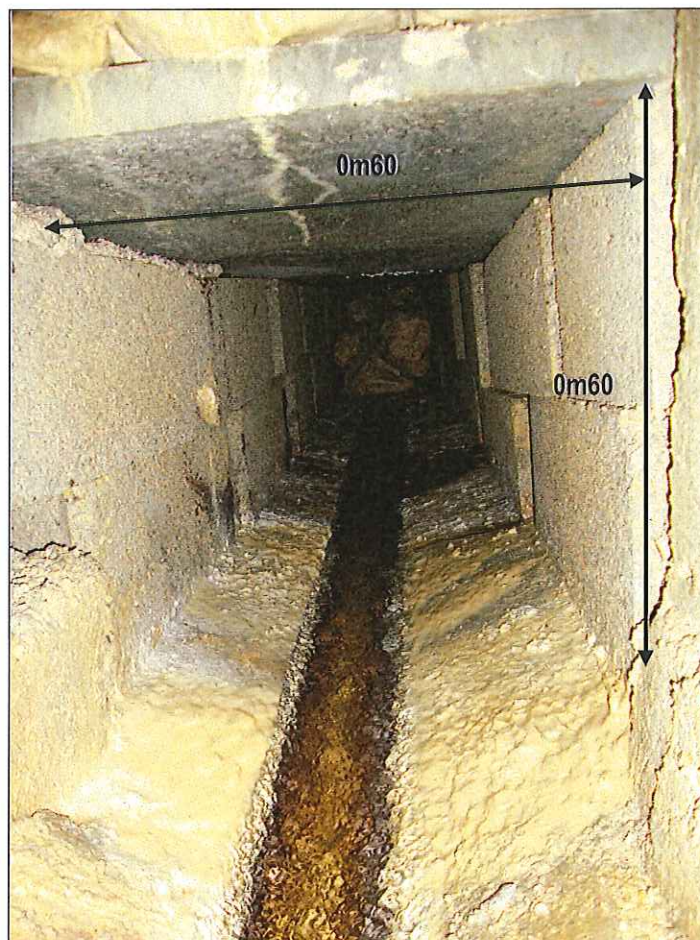
Vue aval-amont du drain de collecte
