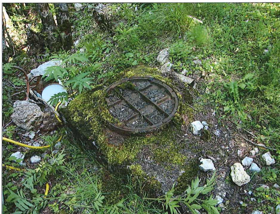
Vue extérieure de l'ouvrage
