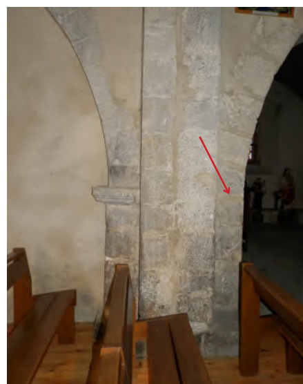
Église de Gresse-en-Vercors, doubleau remanié, cordon mouluré plus large sur la quatrième travée et absence de pile surmontée d'une imposte moulurée - Octobre 2021 - Crédit photos : Amandine Moskal
