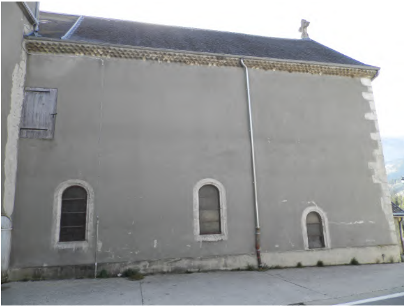
Ouverture des 3 baies au Nord dans l'axe des 3 baies Sud existantes
