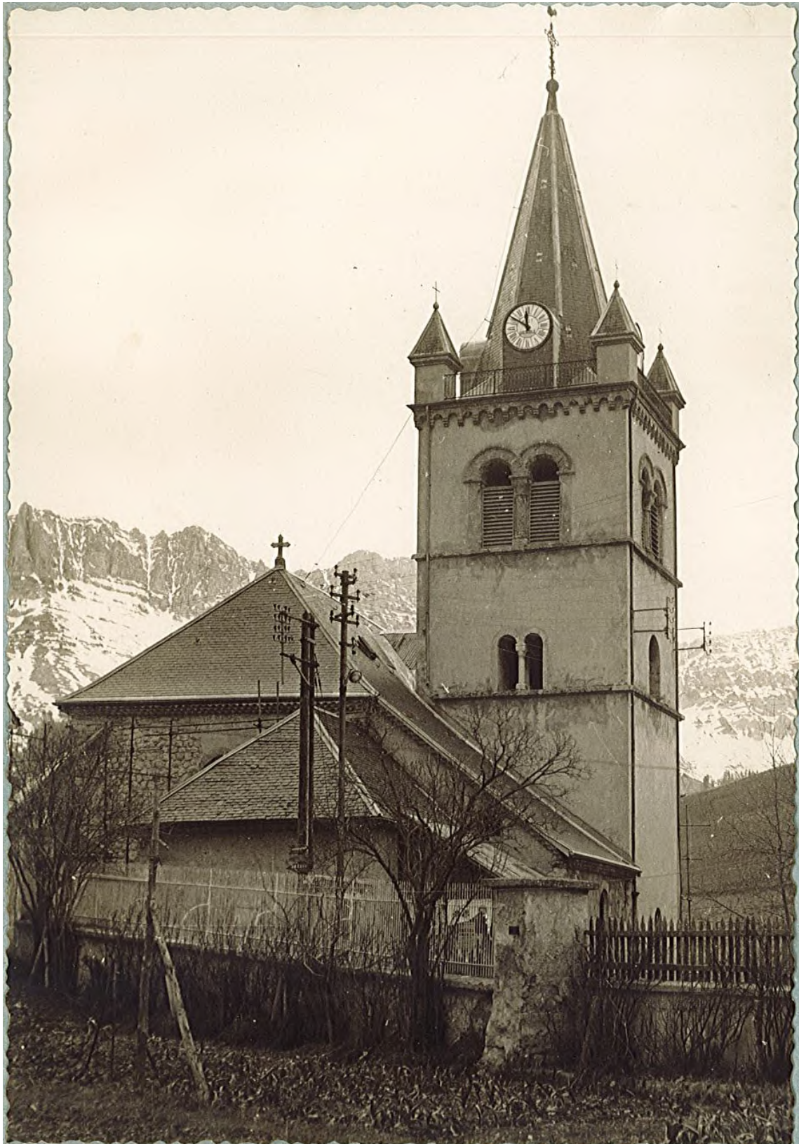
Photos en cours de travaux de 1959 - Archives Municipales de Gresse-en-Vercors
