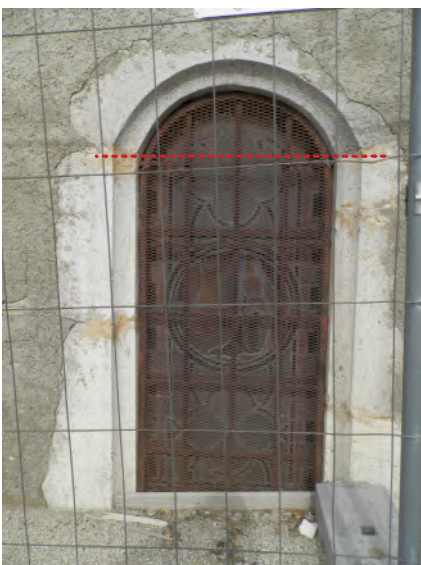
Baie Sud de la chapelle - Arc surbaissé
