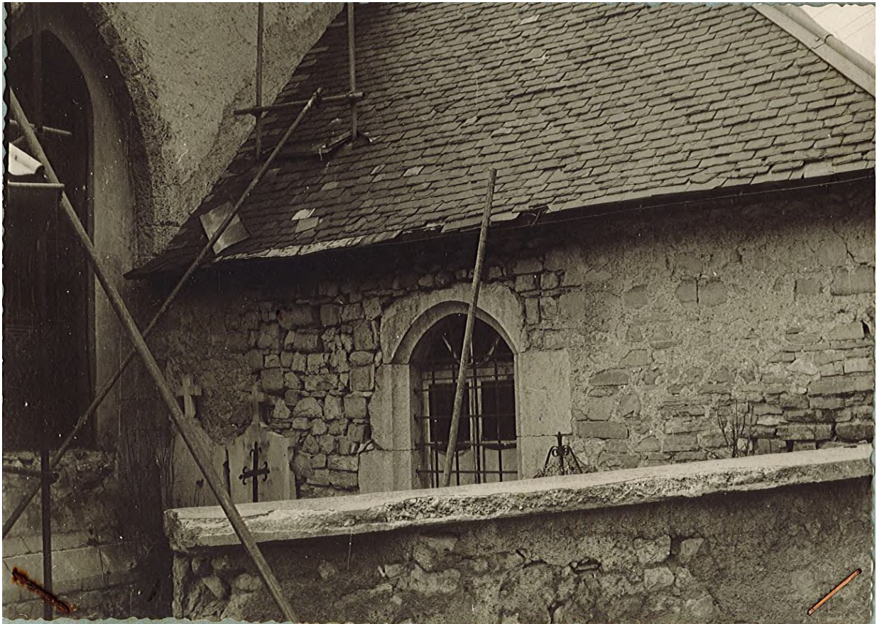
Photos en cours de travaux de 1959 - Archives Municipales de Gresse-en-Vercors
