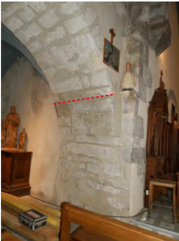
Reconstruction de l'arcade Nord du clocher, seul la base de nature de pierre différente semble avoir été conservée
