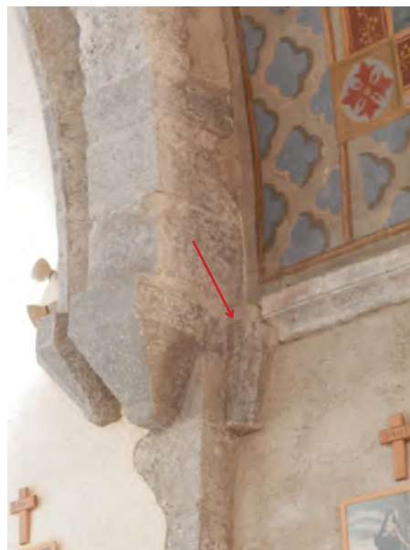
Cul de lampe en attente, ressaut de la maçonnerie
