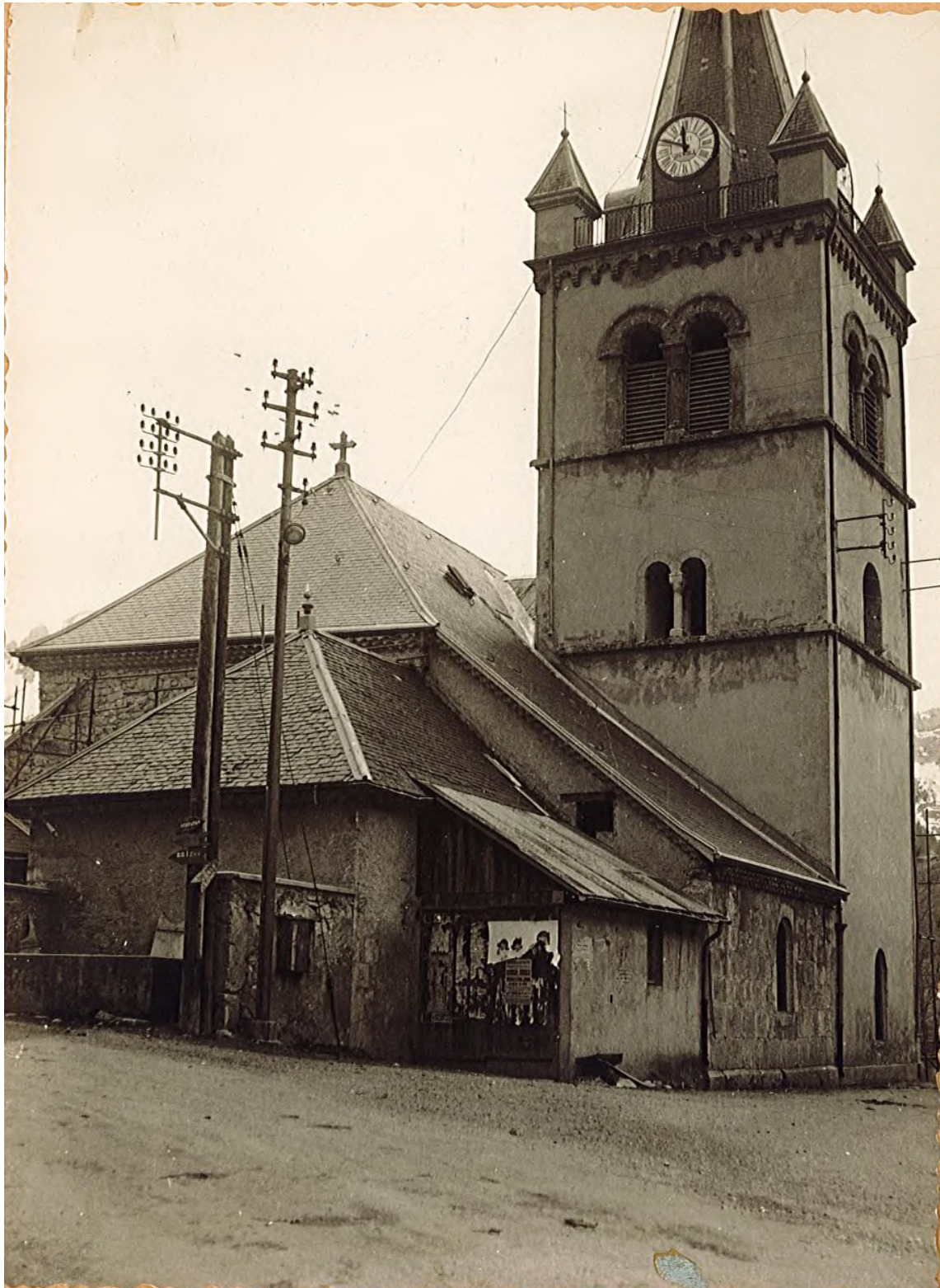
Photos en cours de travaux de 1959 - Archives Municipales de Gresse-en-Vercors
