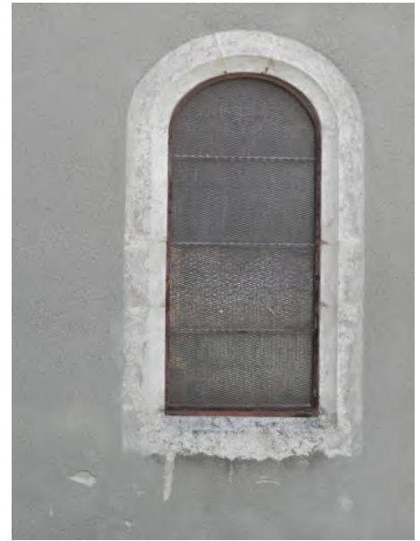
Baie en pierre de taille calcaire homogène, linteau en arc surbaissé avec clef d'arc
