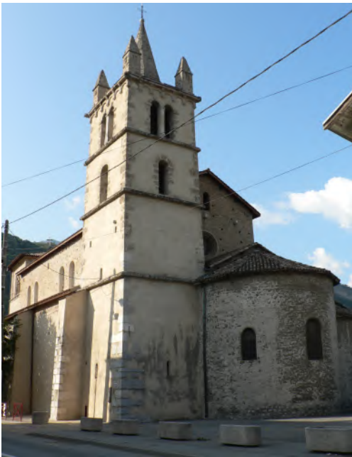
Église romane Saint-Jean-Baptiste à Vif, remaniée, Nef centrale contreboutée par des bas côtés Source photo : https://fr.wikipedia.org
