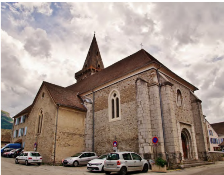
Église romane Notre-Dame de Mens, Nef centrale contreboutée par des contreforts datés du début du 13 e siècle. 10 Source photo : https://www.france-voyage.com
