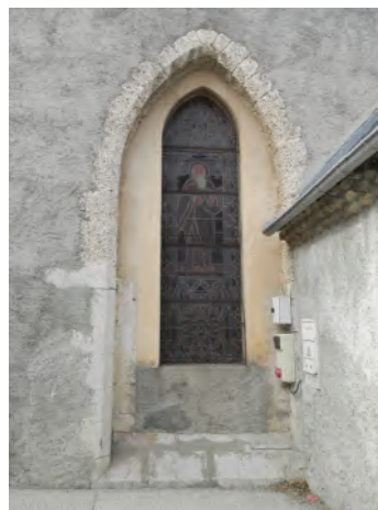
Baie axiale du chœur remaniée en Tuf sur piédroits et arc brisé
