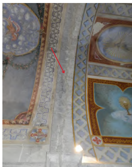
Église de Gresse-en-Vercors, doubleau remanié, cordon mouluré plus large sur la quatrième travée et absence de pile surmontée d'une imposte moulurée - Octobre 2021 - Crédit photos : Amandine Moskal
