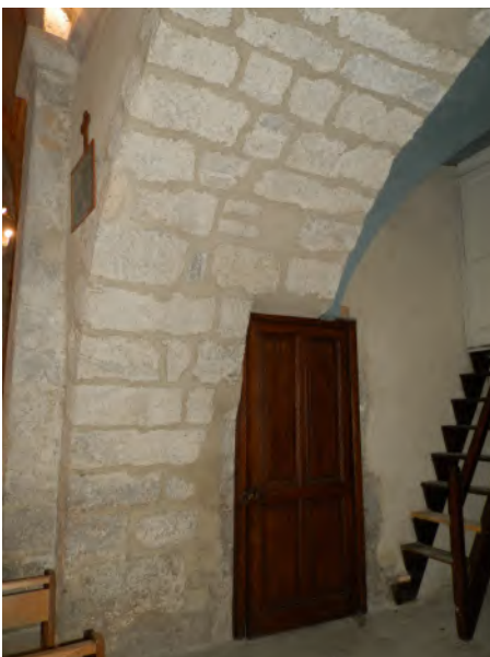
Reprise de l'arc et de la porte en sous oeuvre
