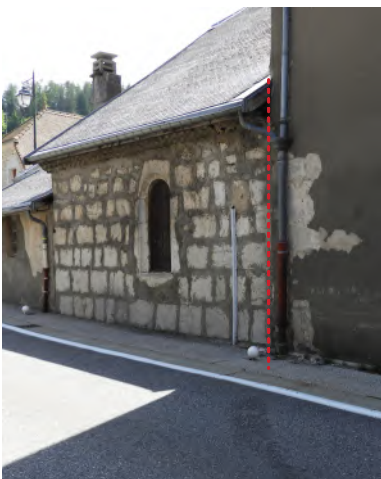
Chapelle Nord accolée au clocher, en grand appareil calcaire, contrairement aux autres maçonneries en petits moellons enduits.
