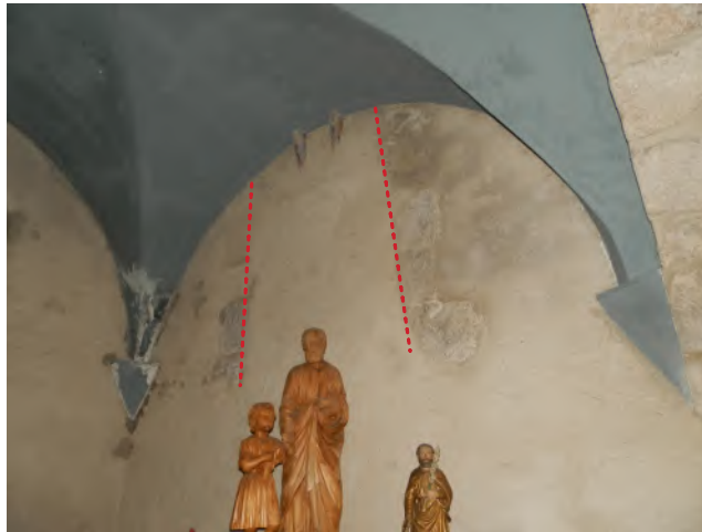
Ancienne baie de la chapelle du clocher comblée lors de la construction de la chapelle Nord, accolée au clocher.
