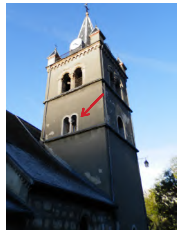
Reconstruction totale du clocher : Baies géminées en pierres calcaires en réemploi
