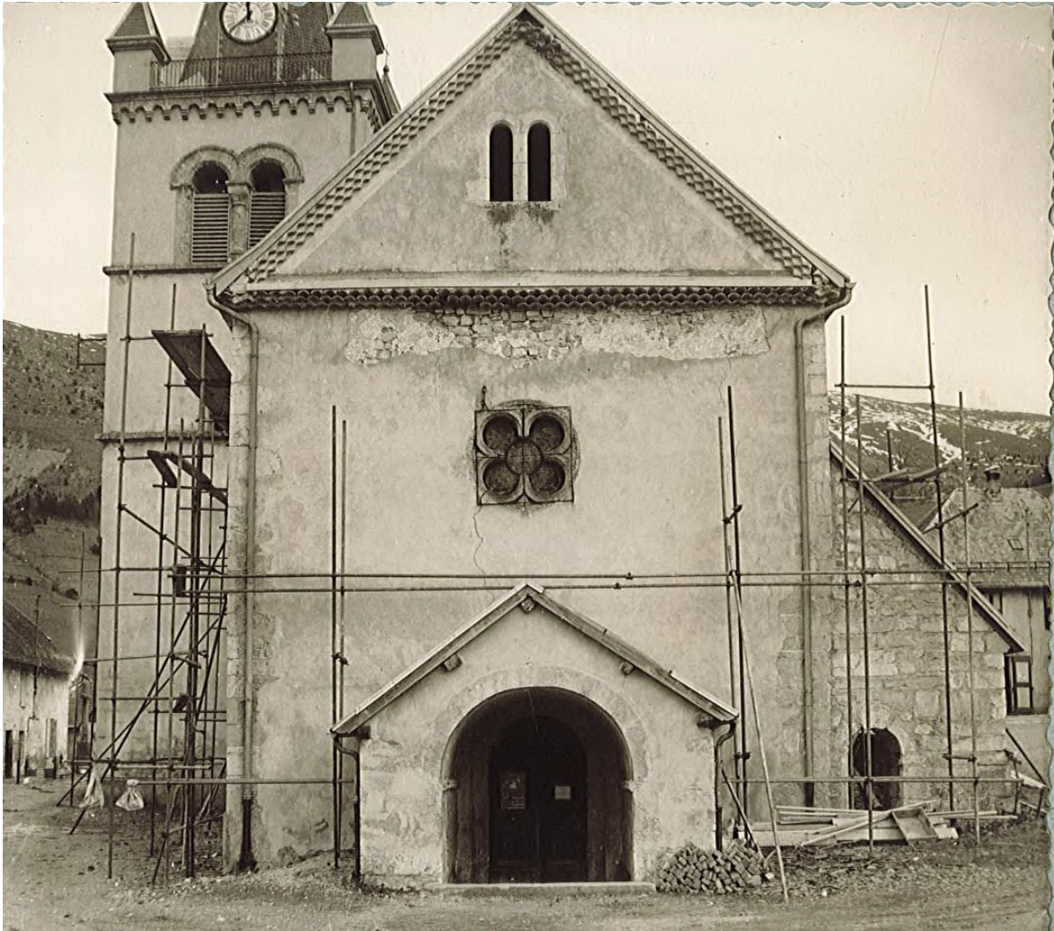
Photos en cours de travaux de 1959 - Archives Municipales de Gresse-en-Vercors
