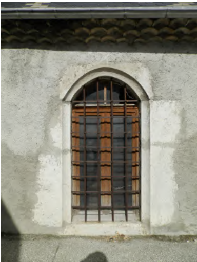
Ancienne porte de la sacristie remaniée en baie
