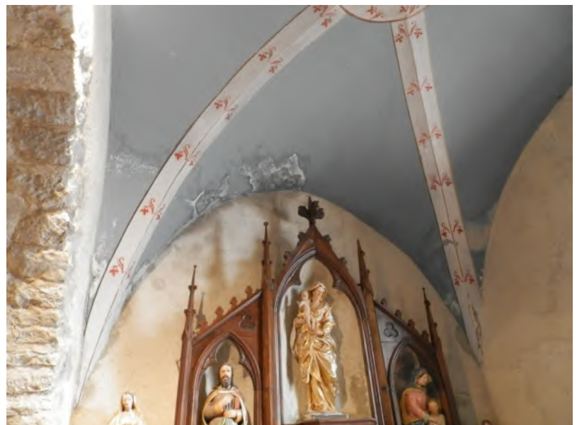
Reconstruction de la voûte d'arrête en brique enduite à la chaux
