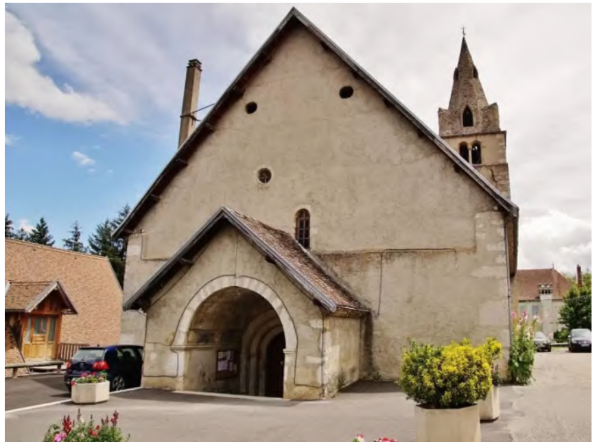
Église romane Sainte-Marie de Clelles, façade écran avec un porche à l'entrée. Présence de chapelles latérales pour contrebouter la nef centrale - Absence de contreforts Source photo : https://www.trieves-vercors.fr
