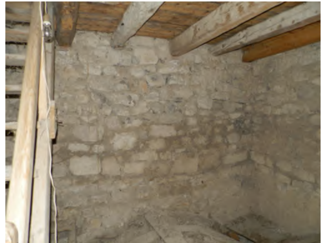
Maçonneries de moellons calcaires - Clocher
