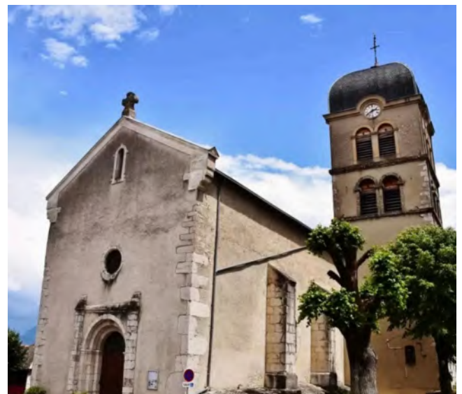
Église romane du 13 e siècle, Saint-Pierre et Saint-Paul du Monestier-du-Percy, Nef centrale contreboutée par des contreforts. Source photo : https://www.france-voyage.com
