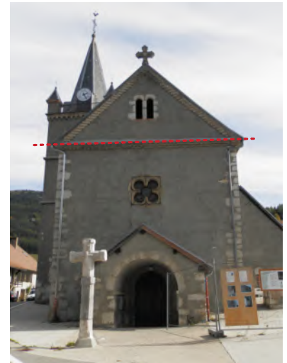
Création du pignon de la façade Ouest
