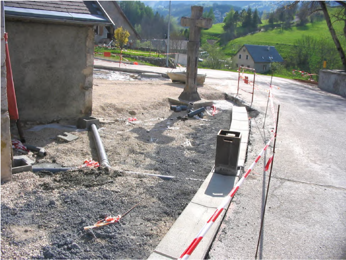
Mise en oeuvre du réseau de drainage des eaux pluviales - 2006
