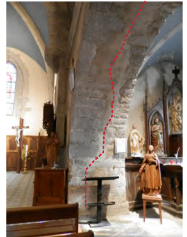
Reconstruction de l'arcade Sud de la chapelle : élargissement de l'arcade à l'origine aveugle.
