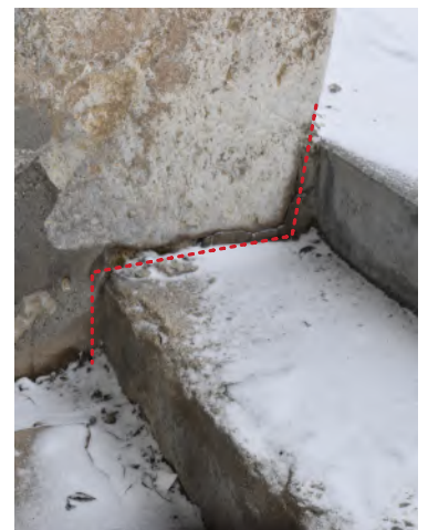
Marches d'escalier du porche postérieures à sa construction. Le niveau de sol d'origine, à l'entrée de l'église, était au même niveau que le sol intérieur.
