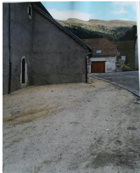
Revêtement sol stabilisé perméable
