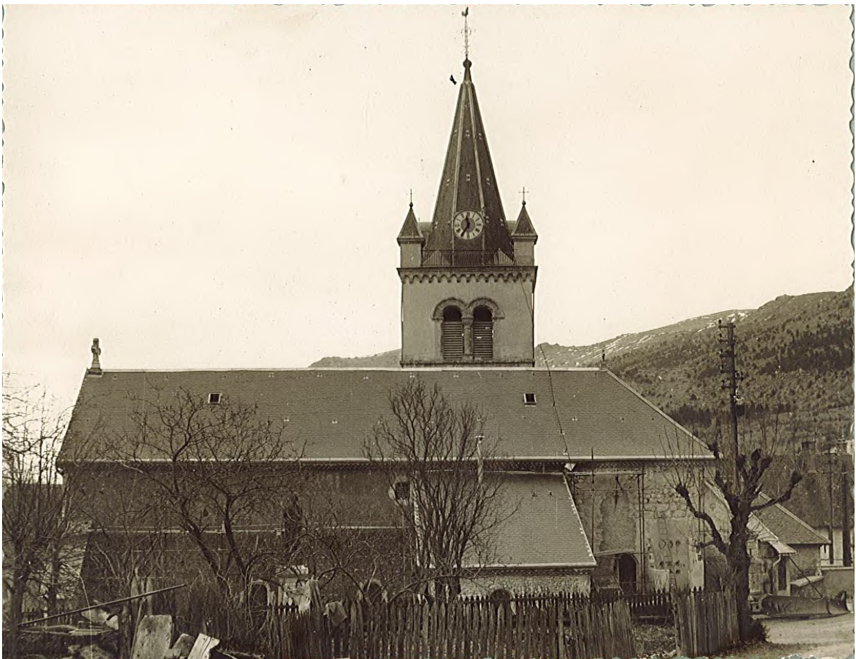
Photos en cours de travaux de 1959 - Archives Municipales de Gresse-en-Vercors
