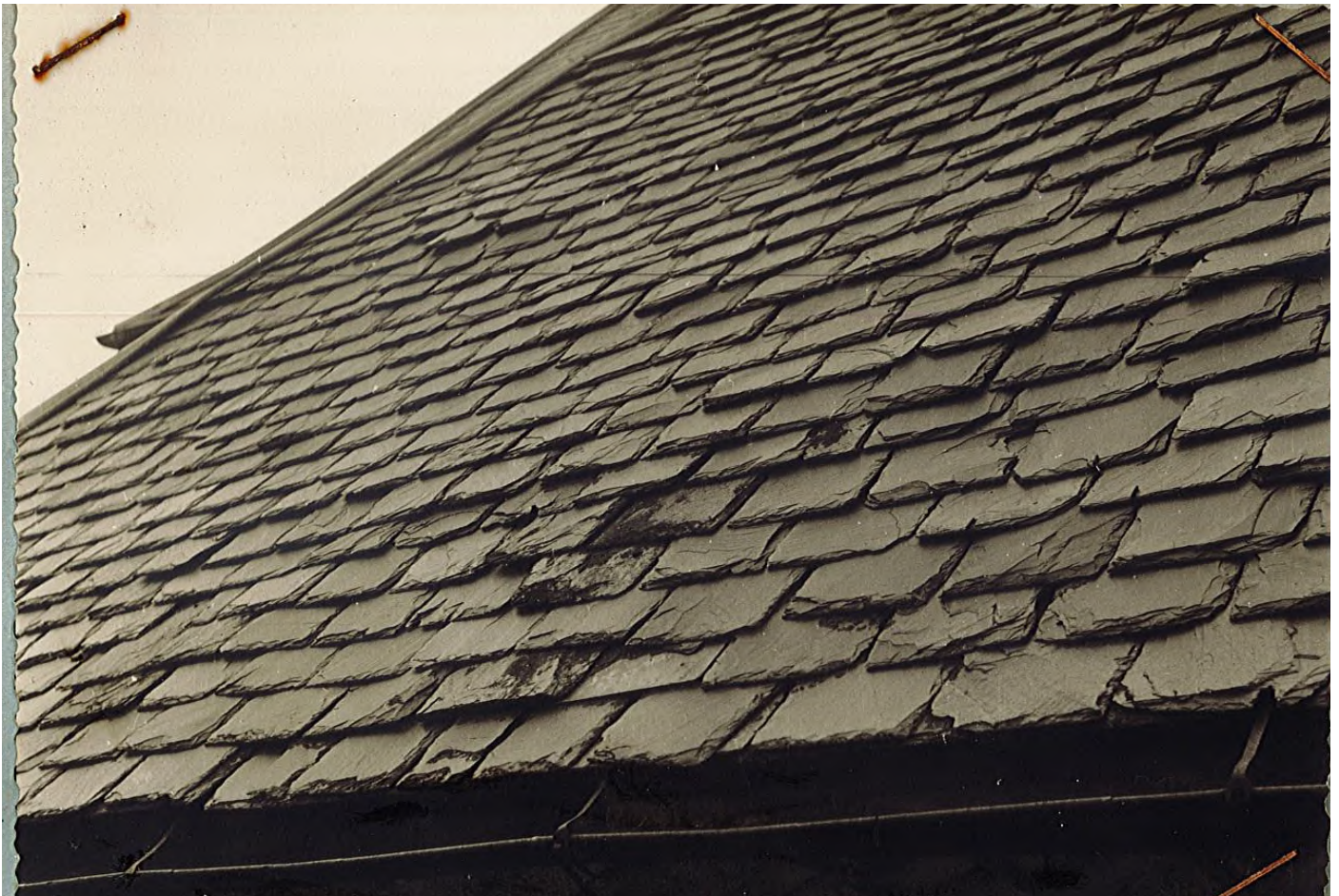
Photos en cours de travaux de 1959 - Archives Municipales de Gresse-en-Vercors
