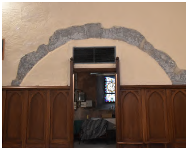
Ancienne arcade aveugle du clocher, créée lors de la construction de la chapelle. Aujourd'hui fermée par une cloison.
