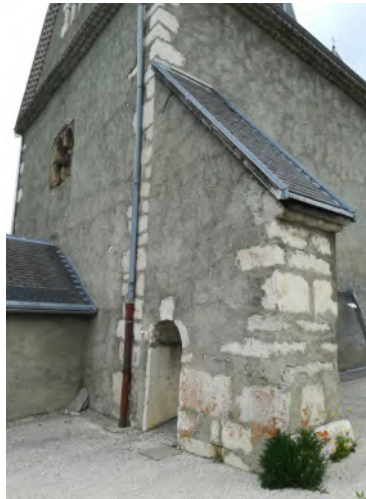
Chaînes d'angle et contrefort en pierre de taille calcaire
