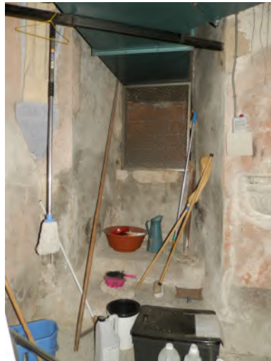
Ouverture de la porte d'accès à la chapelle Nord
