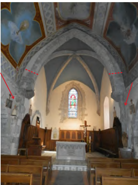
Raccordements maladroits, ressauts, arc doubleau de nature de pierre différentes
